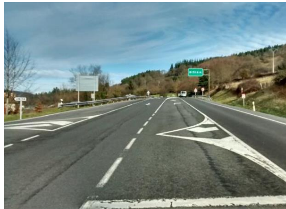
Intersección sur. Carril de espera
